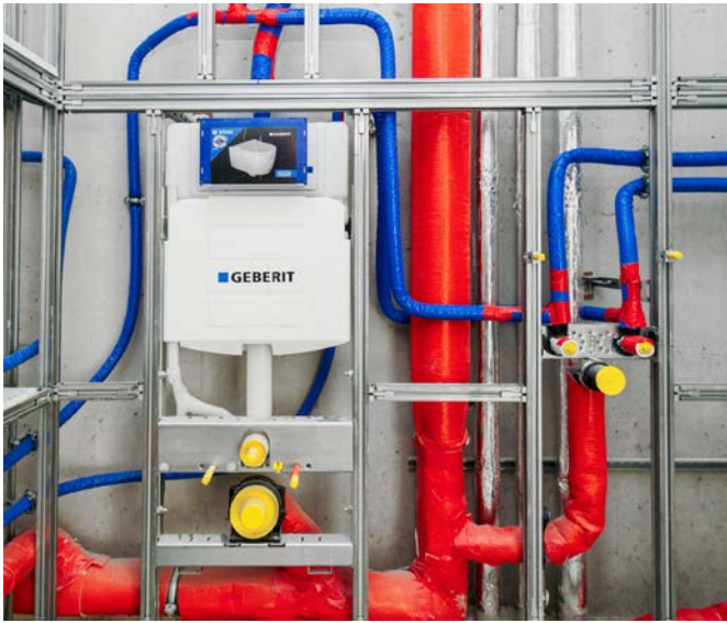
↑ GIS Montaj Sistemi 1993 yılında tanıtılan GIS montaj sistemi, Geberit'in alçıpan tipi duvar yapımında hijyenik ön duvarlar oluşturma çözümüdür. Özellikle tam hijyenik duvarların prefabrikasyonu için uygundur, bu da inşaat sahasında montajı hızlandırır.
